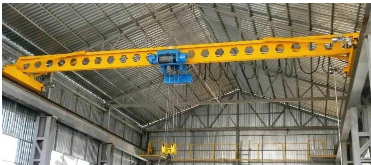
Рис. 2.1 – Перфоровані кран-балки із шестикутними вирізами
