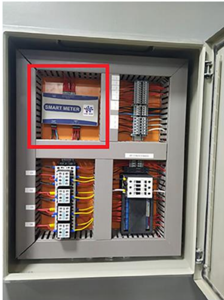
Рис. 2.7. Розподільчий вузол електромережі
