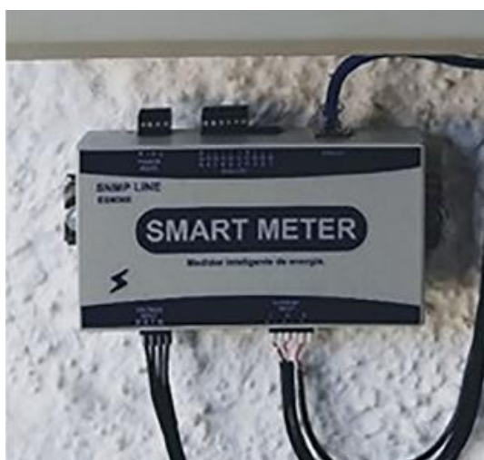
Рис. 3.3. Вигляд розумного лічильника, вмонтованого у розподільчий трансформатор
