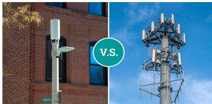
Рис. 2.31. Рішення small cells (ліворуч), порівняно із звичайною базовою станцією Macro BTS у мережі попередніх поколінь
