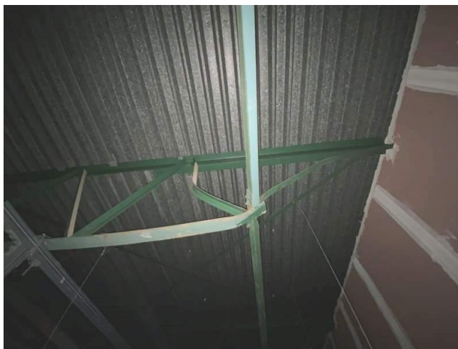
Рисунок 1.12 – Втрата стійкості опорного розкоса
