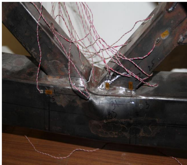
Рисунок 1.14 – Руйнування К-подібного вузла у фермі з профільної труби [30]
