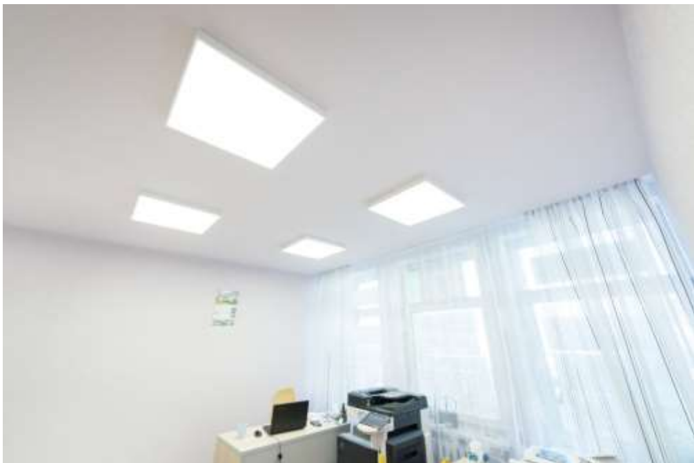
Рисунок 3.2. - HSK LEDY - Світильник Draco D-66 - стандартний панельний світильник 60x60 см [32]
