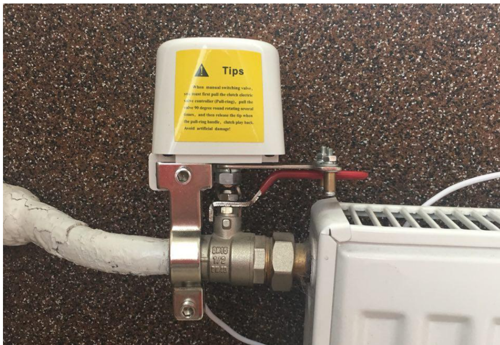
Рисунок 3.18 – Модуль керування радіатором
