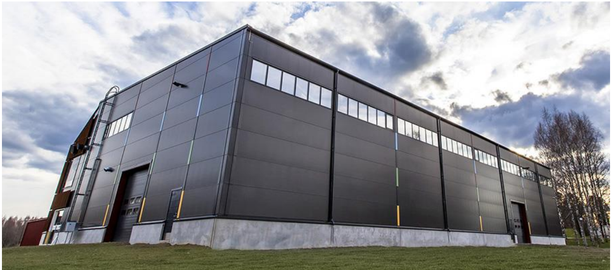
Рисунок 1.3 – Будівництво складської будівлі із сендвіч-панелей
