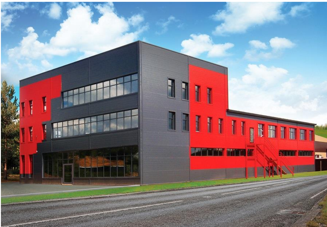
Рисунок 1.2 – Будівництво виробничого приміщення з адміністративним корпусом [3]
