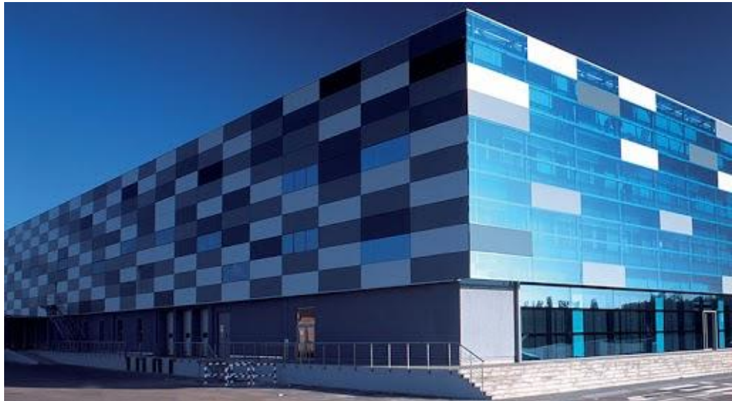
Рисунок 1.1 – Будівництво логістичного центра із сендвіч-панелей
