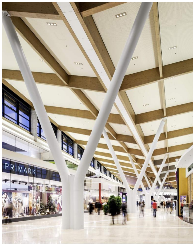
Рисунок 1.5 – Конструкція будівлі з використанням нахилених колон
