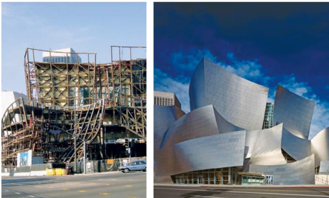
Рисунок 2. Несучий каркас і зовнішня оболонка концертного залу ім. Уолта Діснея, Лос Анджелес, США
