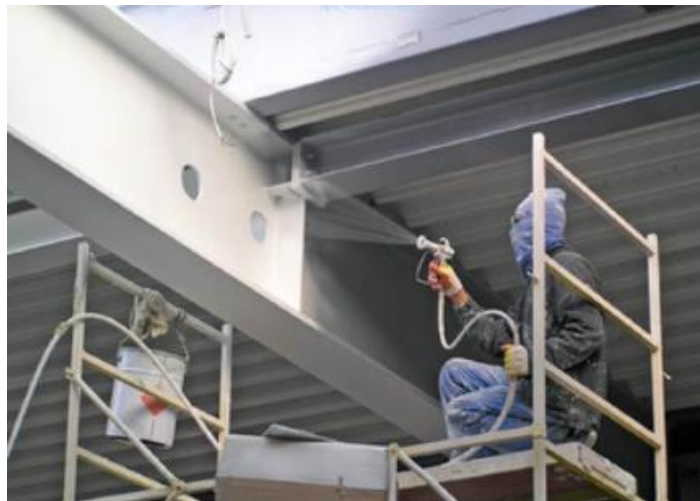
Рисунок 2.16 – Нанесення вогнезахисного покриття на металеві конструкції
