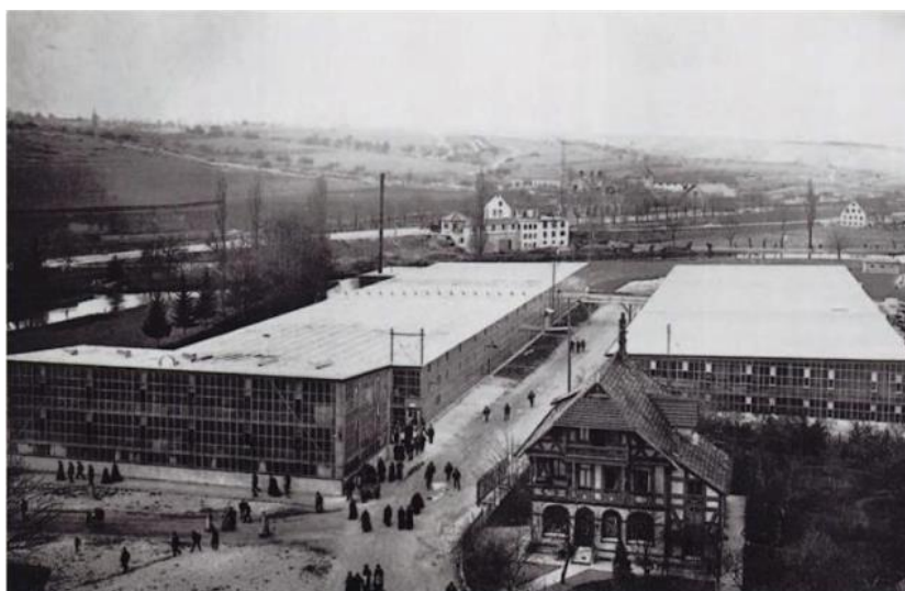
Рисунок 1.4 – Східний блок 1903 року - це парадний павільйон зліва, інші будівлі побудовані між 1904 і 1908 роками (фото 1920-х років [13])
