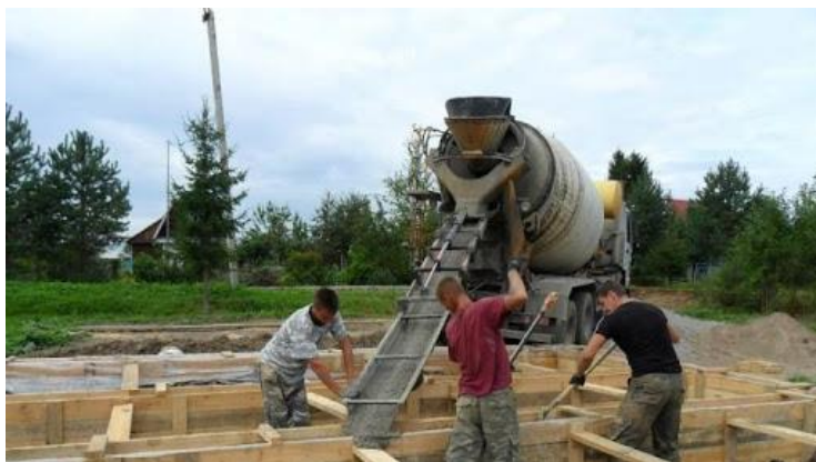
Рисунок 1.1 – Заливка бетонної суміші при підвищеній температурі
