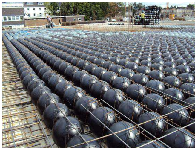
Рис. 3.4. Система полегшення залізобетонних плит Cobiax
