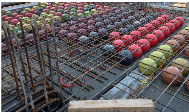
Рис.3.5 Зведення плити за технологією BubbleDeck
