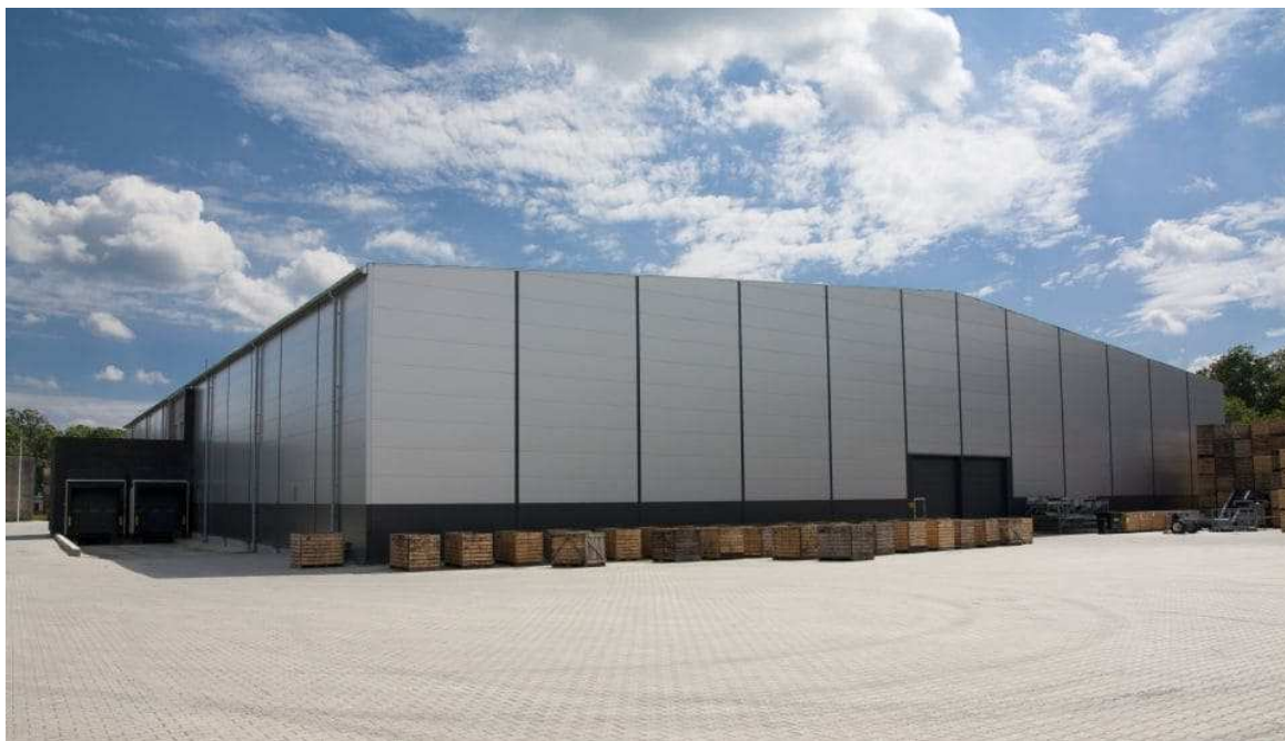
Рис.3.2 Загальний вигляд будівлі оздобленої сендвіч-панелями
