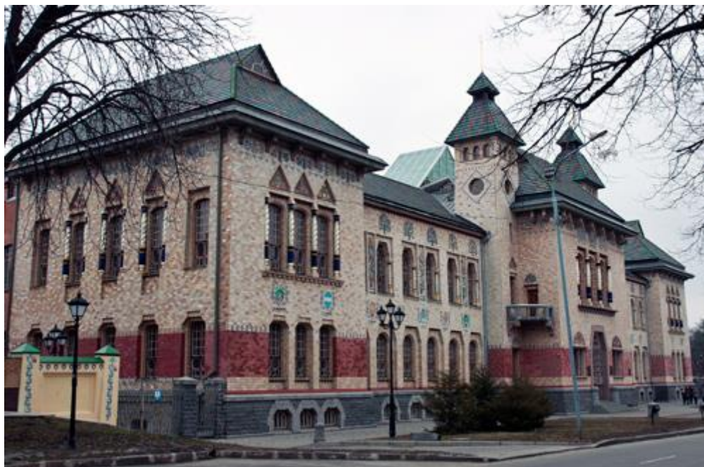
Рисунок 1.1 – Зображення будівлі Полтавського краєзнавчого музею імені Василя Кричевського
