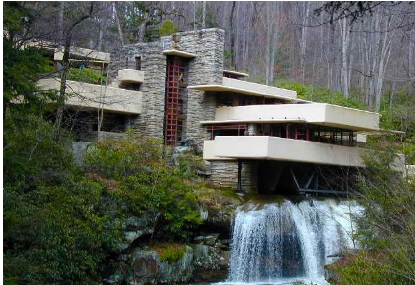
Рисунок 2.5 - Будинок над водоспадом
