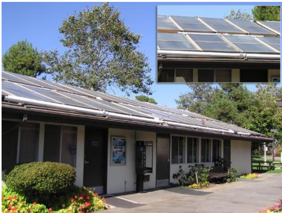
Рисунок 3.9 - Будинки з панелями фотоелементів на похилому даху
