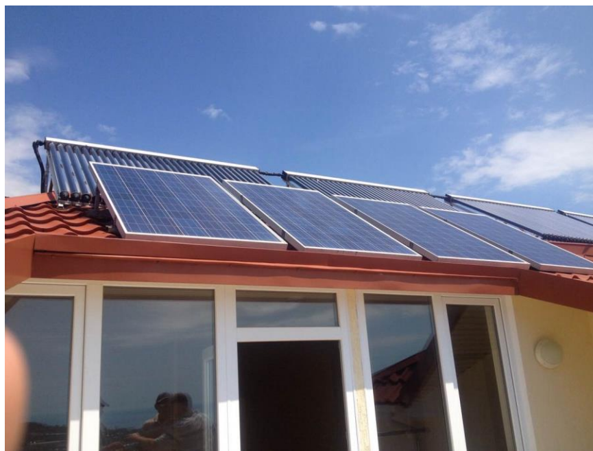
Рисунок 1.1 – Комбінована геліоустановка
