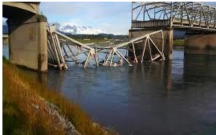
Рисунок 1.1 – Аварії металевих фермових конструкцій
