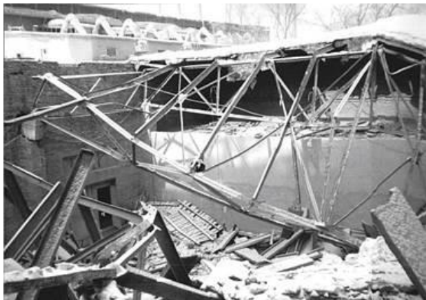
Рисунок 1.1 – Аварії металевих фермових конструкцій
