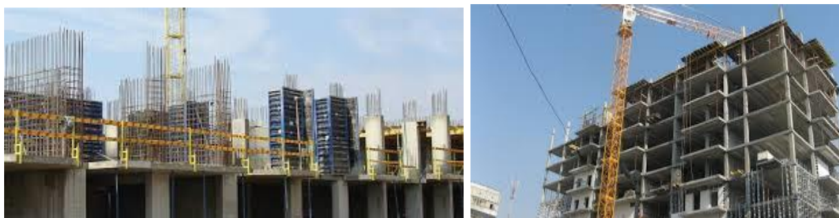
Рис. 1. Монолітні каркасні будівлі
