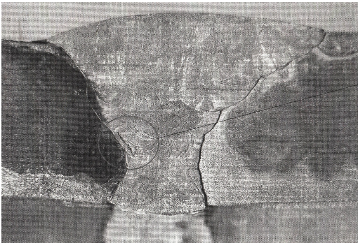
б) тріщина кореня шва
