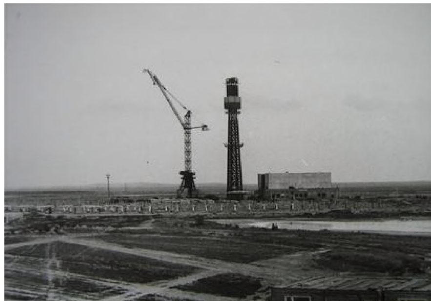
Рис. 1.8. СЕС-5 під час будівництва
