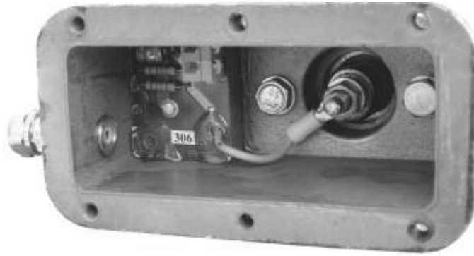
Рисунок 2.4 Давач DB-2 фірми IRIS (Канада) встановлений на ввід
