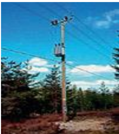
Рисунок 5.3 - Однофазова трансформаторна підстанція
