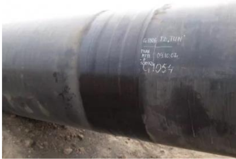
Рис. 1.3. Приклад захисту зварного шва поліпропіленовим покриттям
