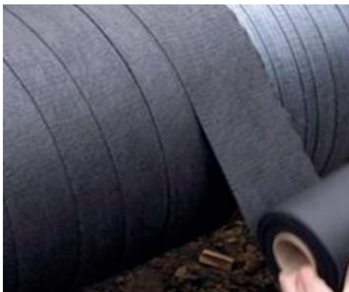
Рис. 1.2. Нанесення поліпропіленової стрічки на поверхню газопроводу
