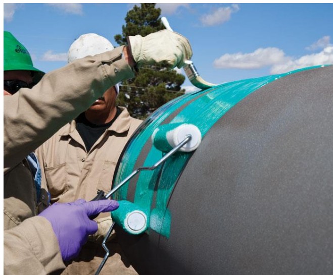
Рис. 1.6. Нанесення епоксикомпозитних покриттів: а – розпиленням; б - пензлем, https://napipelines.com/pipeline-protection-coating/feat-coat-1/#prettyPhoto/0/
