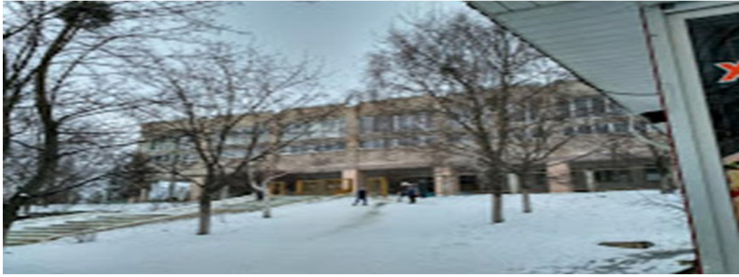
Рис. 3. Загальний вигляд будівлі школи
