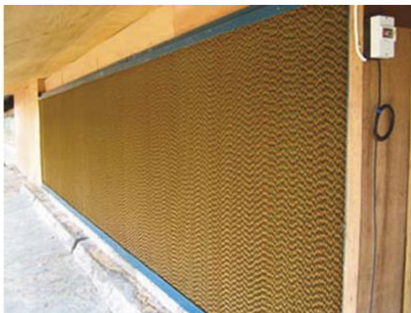
Рис. 1.15. Касети випарного охолодження
