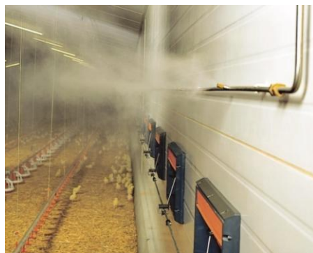
Рис. 1.12. Система форсунок низького тиску
