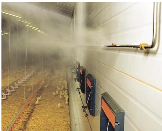
Рис. 1.8. Система форсунок низького тиску
