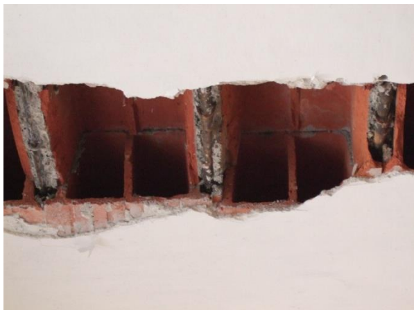
Рис. 1. Ділянка «1»: Вигляд знизу збірно-монолітного перекриття 1-го поверху
