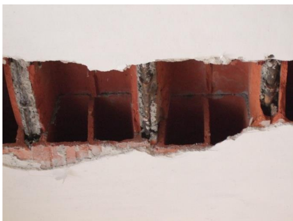
Рис. 1. Ділянка «1»: Вигляд знизу збірно-монолітного перекриття 1-го поверху
