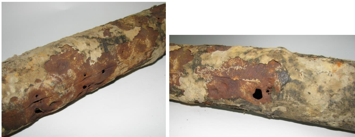
Рис. 1. Фрагменти сталеві труби підземного газопроводу низького тиску (Ø 60 мм) з наявними електрокорозійними дефектами типу «свищ»
