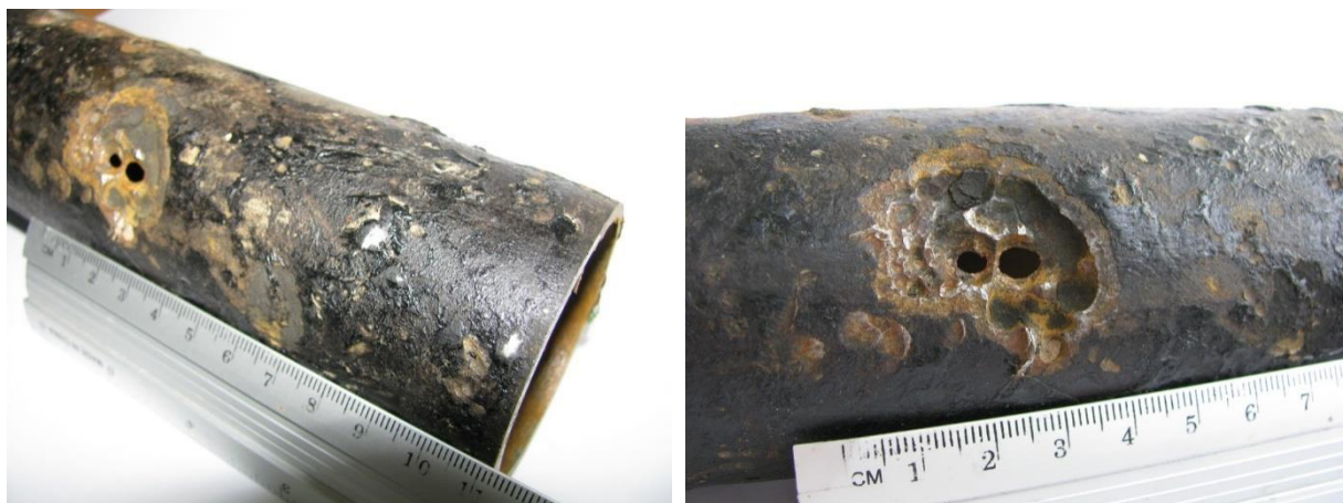
Рис. 2. Фрагменти сталеві труби підземного газопроводу низького тиску з характерними ознаками електрокорозійного пошкодження вирізані в місці аварійного витоку природного газу
