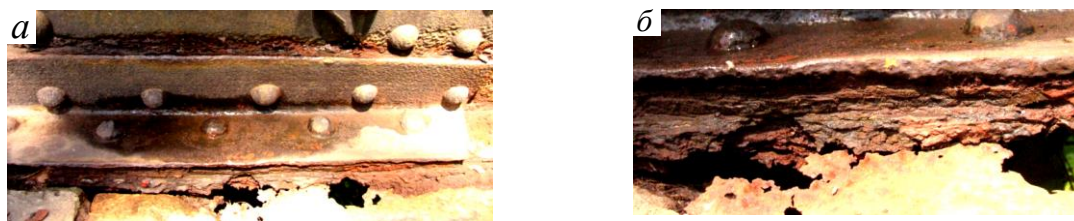
Рис. 2. Розшарування з торця горизонтальної полицки пакетного обруча.
