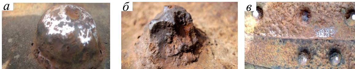
Рис. 5. Етапи руйнування автентичних заклепок на вежі Шухова
