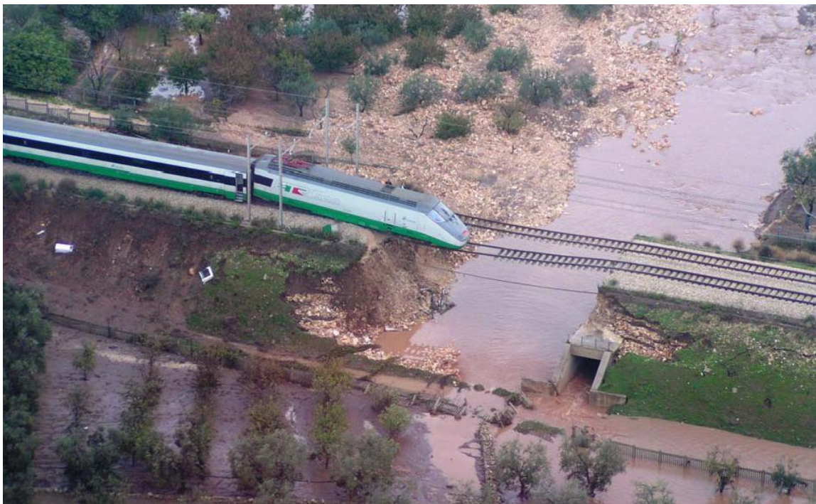
Рис. 1.10. Зруйнована ґрунтова дамба під залізничним полотном [376]
