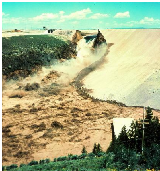
Рис. 1.10. Зруйнована ґрунтова дамба під залізничним полотном [376]
