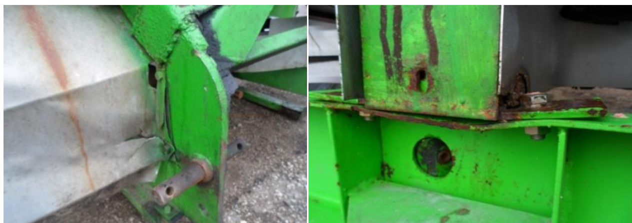
Рис. 1.16. Заварені корозійно - втомні тріщини металоконструкції розкидача мінеральних добрив
