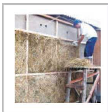
Рис. 3.12 - Зовнішня ізоляція соломою з шаром глини
