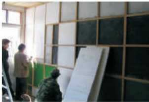
Рис. 3.4 - Приклад внутрішньої теплоізоляції пінопластом з фанерою
