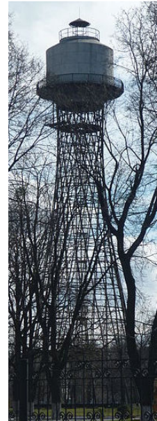
Рисунок 2. Гіперболоїдна вежа на території Черкаського водоканалу [3]
