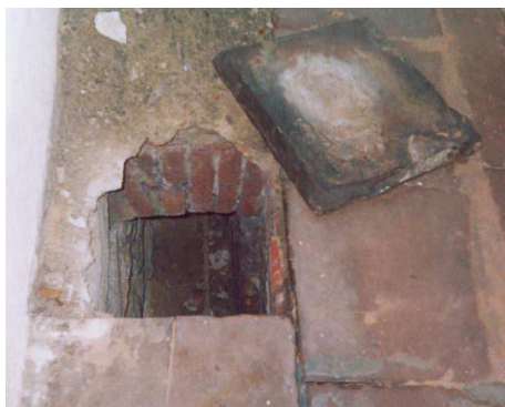
Рис. 2.8. Осушення стін (фундаментів) головного корпусу Львівської політехніки за допомогою зовнішніх вентиляційних екранів-тунелів:
