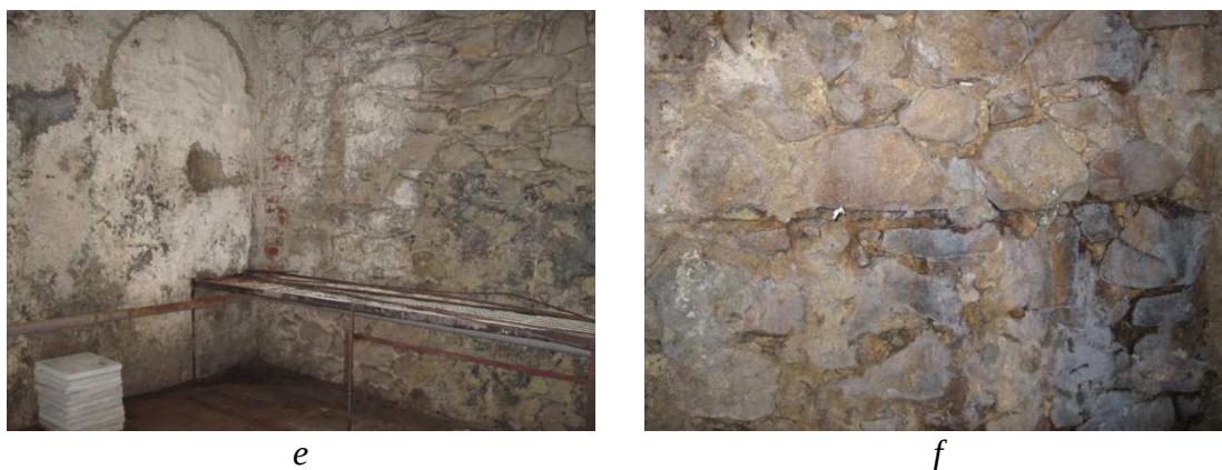
Рис. 2.1. Вигляд обстежуваних стін будівлі зсередини:
