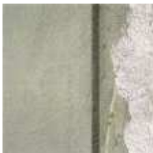
7. Шпаклювання поверхні мінеральною шпаклівкою Thermopal-FS33
