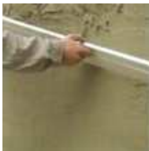
5. Накладання матеріалу Thermopal-SR44
