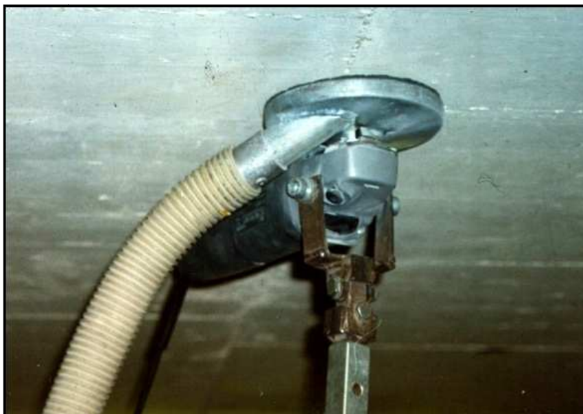
Рис. 45. Фрезування бетонних поверхонь
