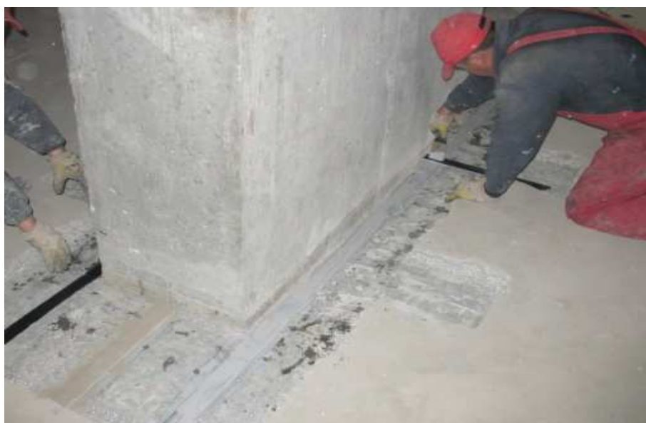
Рис. 44. Виконання посилення приопорних зон по верхніх гранях вуглецевими стрічками
