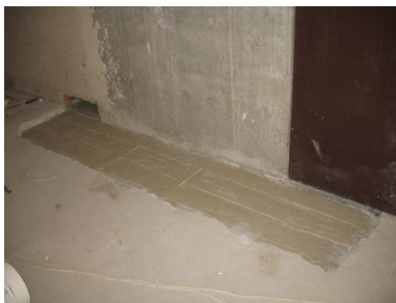
Фото. Приклад виконання посилення на об'єкт
