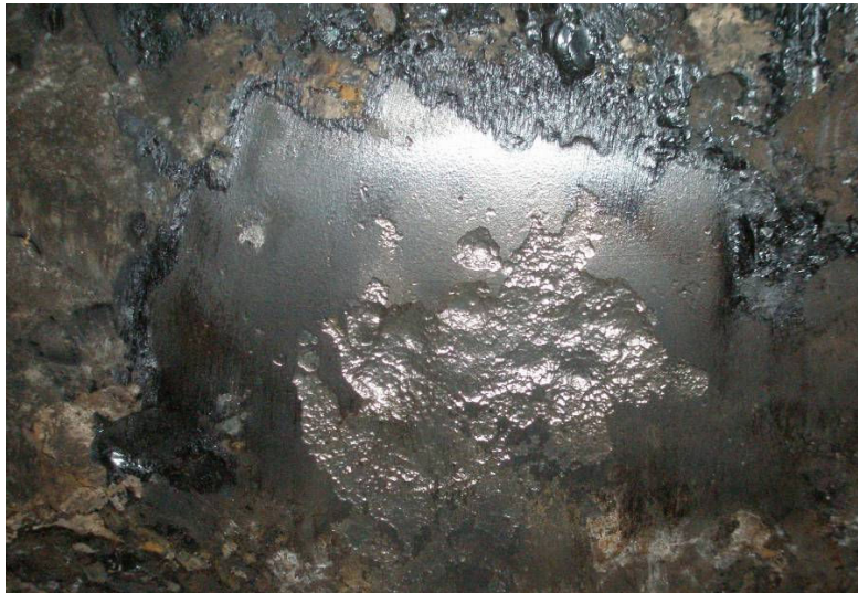
Рисунок 2. Локалізоване корозійне ураження магістрального газопроводу ЄДК
