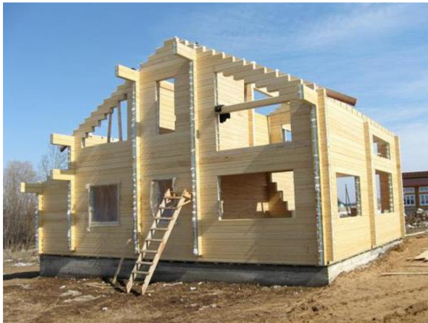
Рисунок 3 - Монтаж здания из клееного бруса.
