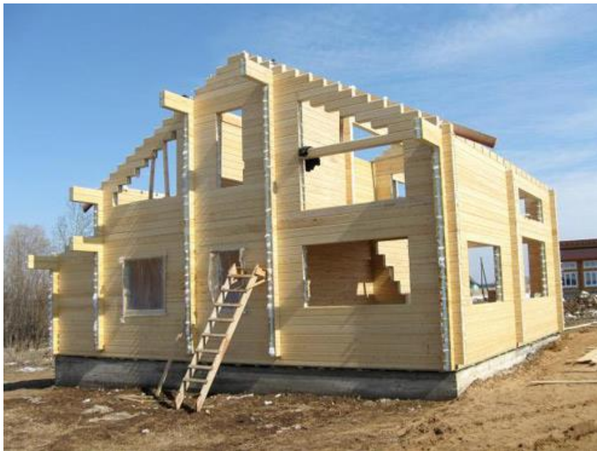
Рисунок 3 - Монтаж здания из клееного бруса.
