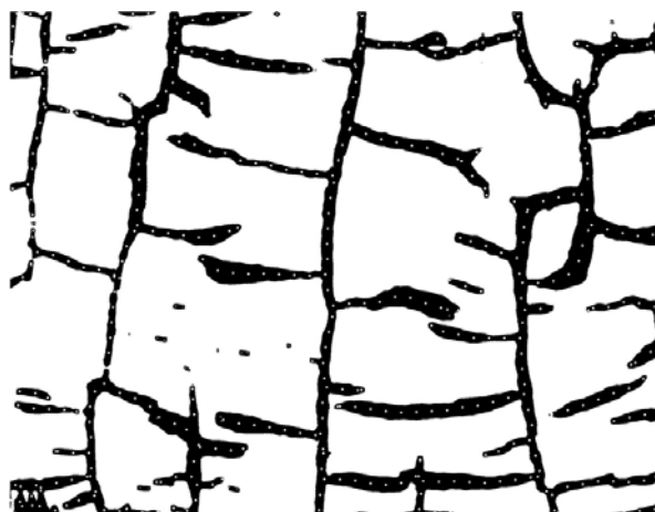
Рис. 5. Конечное изображение с выявленными трещинами и сеткой опорных точек (фрагмент)
