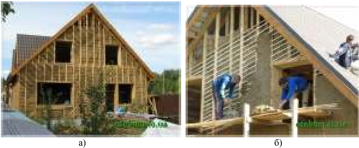
Рис. 1. Видяг будівельного об'єкта до штукатурення (а) і під час штукатурення (б)
